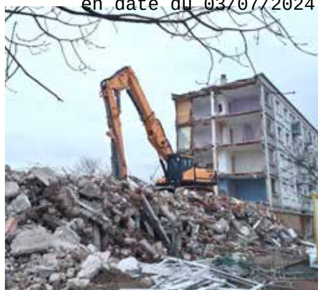
Démolition Rue Léonard de Vinci, Romorantin-Lanthenay
